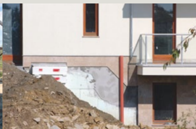
izolacja ścian piwnic
